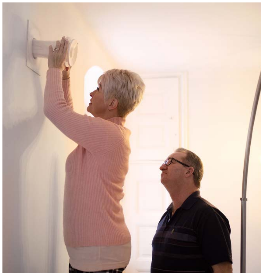
Efter filterbytet sätts ventilen på plats igen. Bild: Suomen terveysilma oy.
