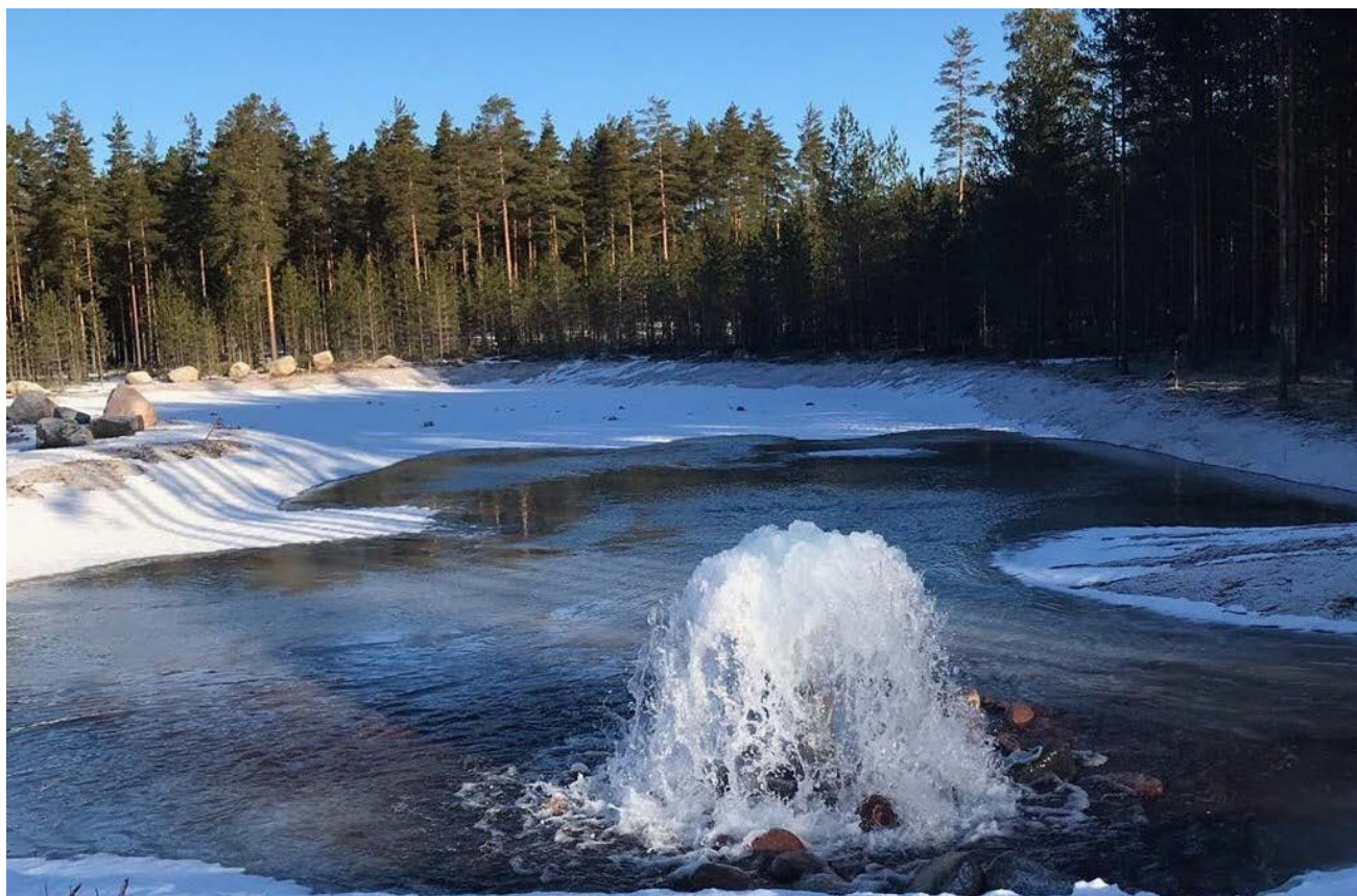
Den nya infiltreringsbassängen IA401. Bild: Turun Seudun Vesi Oy
