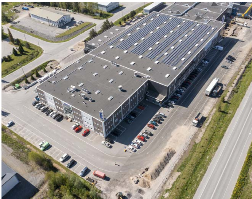
Bild: Schneider Electric
