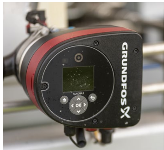
Grundfos MAGNA3-pumpen sparar energi genom AUTOADAPT-funktionen, vilket betyder att pumpen inställer sig efter förbrukningen.
